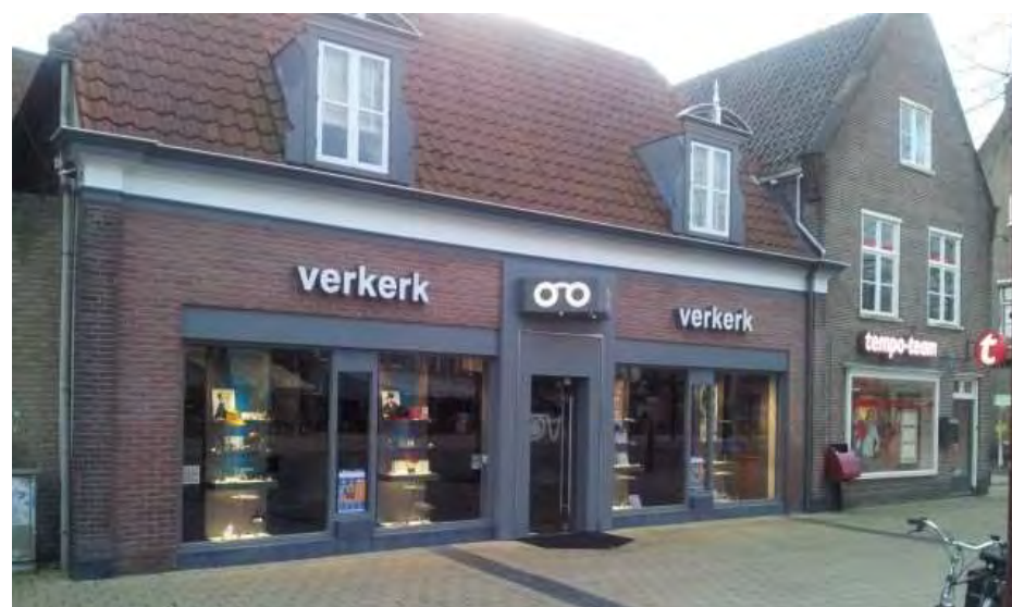
Pui en pand vormen een eenheid
