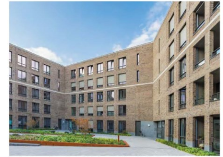
Vooronten aan binnenplaats; Sphinxkwartier, Maastricht (Bedaux De Brouwer)
